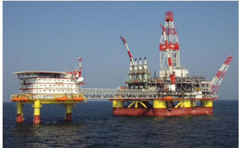
Рис.1. Морская ледостойкая стационарная платформа им. Ю.Корчагина, состоящая из производственного блока ЛСП-1 и жилого блока ЛСП-2, соединенных переходным мостом
