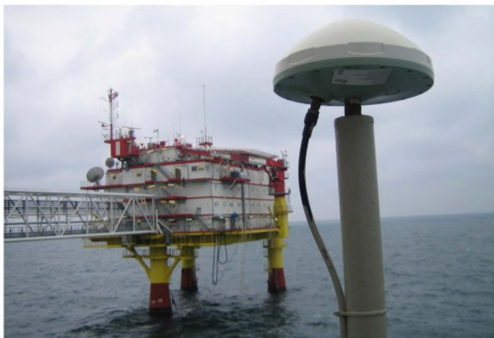
Рис.3. Контрольная точка спутникового мониторинга деформаций ЛСП-1
